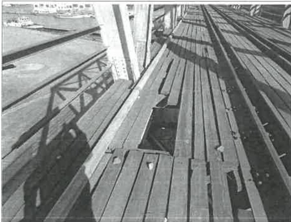
27. Widok na nawierzchnie na obiekcie
