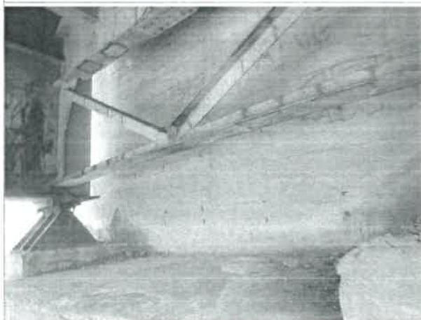
15. Widok na przyczółek
