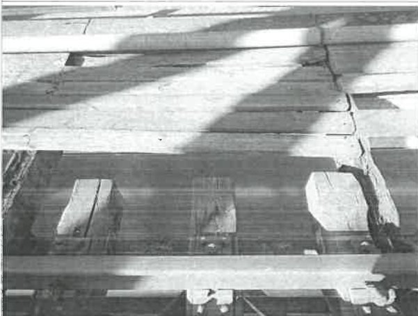
31. Widok na nawierzchnie na obiekcie
