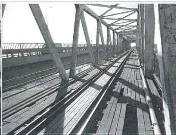
34. Widok na nawierzchnie na obiekcie
