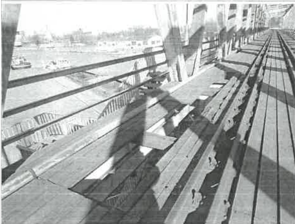
29. Widok na nawierzchnie na obiekcie
