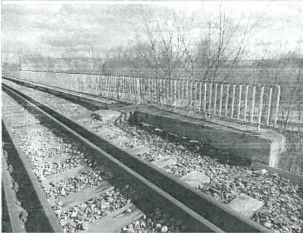
5. Widok na nawierzchnie, balustradę oraz skrzydło
