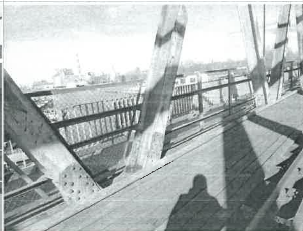
23. Widok na kratownicę
