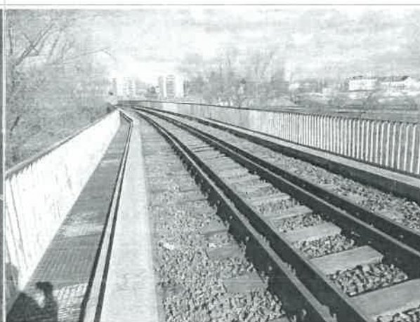
36. Widok na nawierzchnie w części konstrukcji blachownicy
