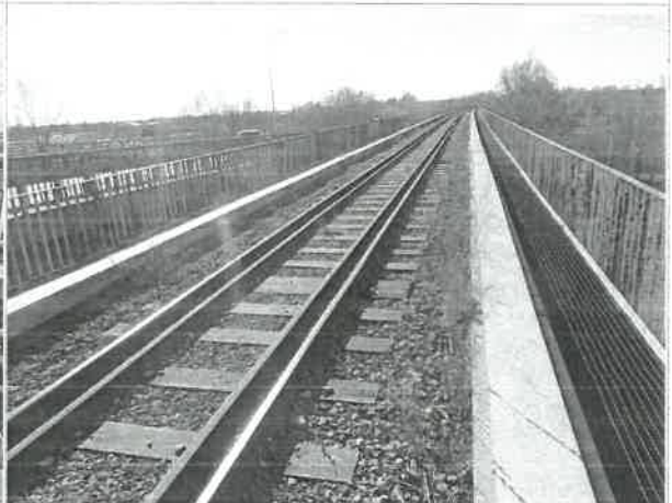
10. Widok na nawierzchnie, dźwigar oraz chodnik na blachownicach
