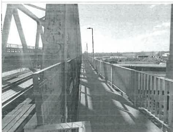
35. Widok na chodnik w części konstrukcji kratownicowej
