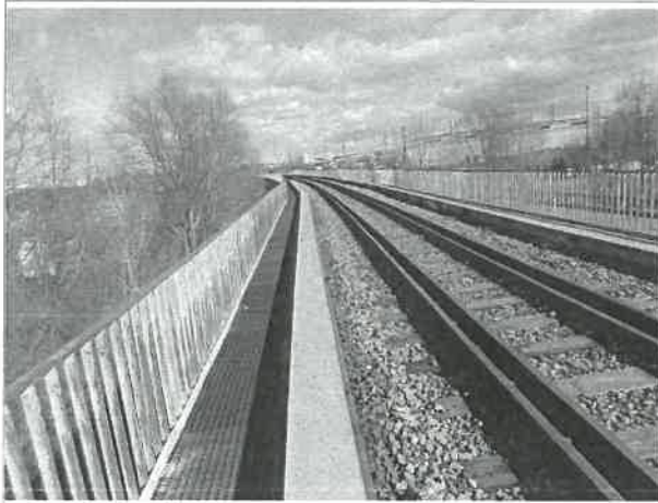
7. Widok na nawierzchnie, dźwigar oraz chodnik na blachownicach.
