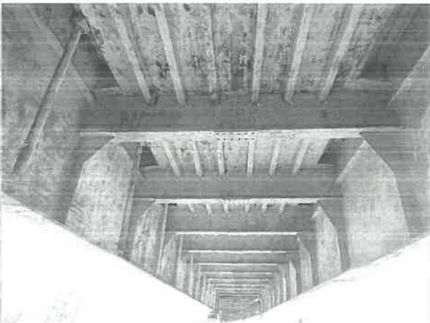
11. Widok na przęsto blachownicowe od spodu
