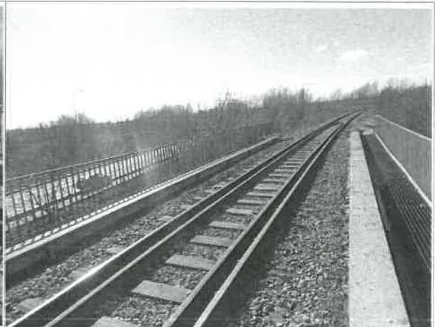
8. Widok na nawierzchnie, dźwigar oraz chodnik na blachownicach
