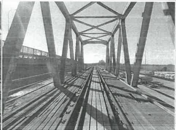
19. Widok na kratownicę
