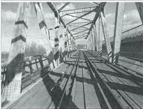
20. Widok na kratownicę
