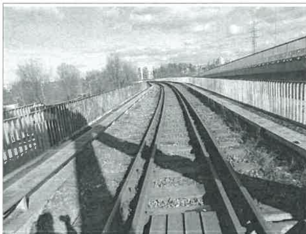
33. Widok na nawierzchnie na obiekcie
