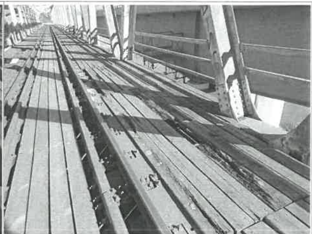
28. Widok na nawierzchnie na obiekcie
