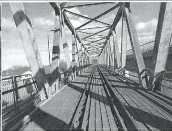
21. Widok na kratownicę
