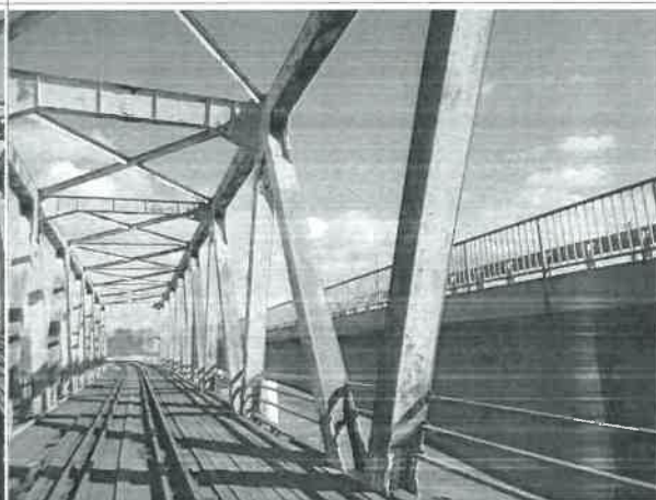
25. Widok na kratownicę
