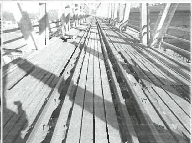
30. Widok na nawierzchnie na obiekcie
