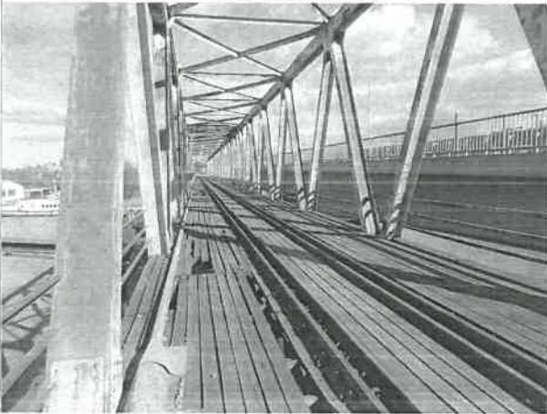
18. Widok na kratownicę
