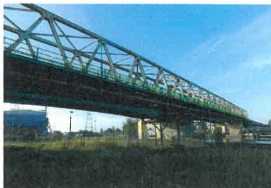
2. Widok z boku na część kratownicową mostu
