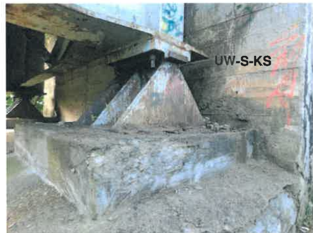
Fot. 25 Korozja powierzchniowa na łożysku stałym na przyczółku zachodnim.
