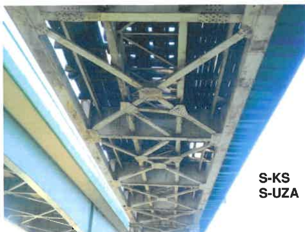
Fot. 2 Widok na spód konstrukcji kratowej. Korozja powierzchniowa.
