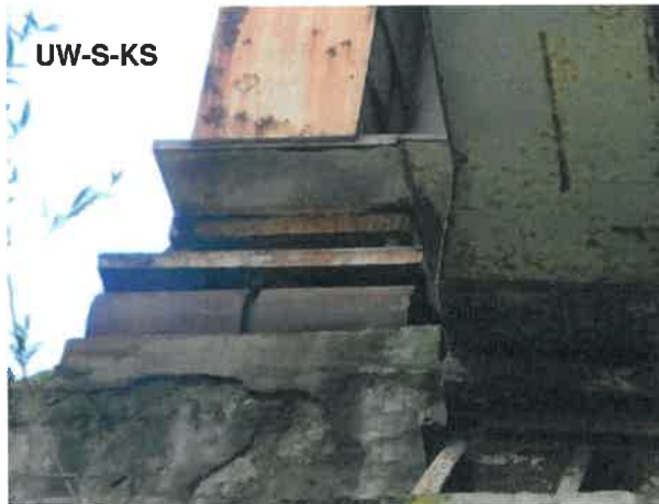
Fot. 24 Widoczne łożysko ruchome konstrukcji kratowej.
