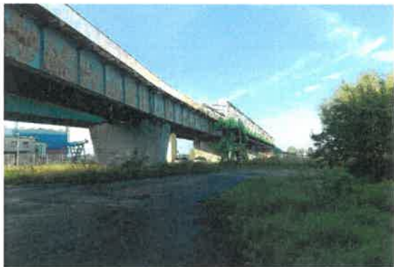
1. Widok z boku na część blachownicową mostu
