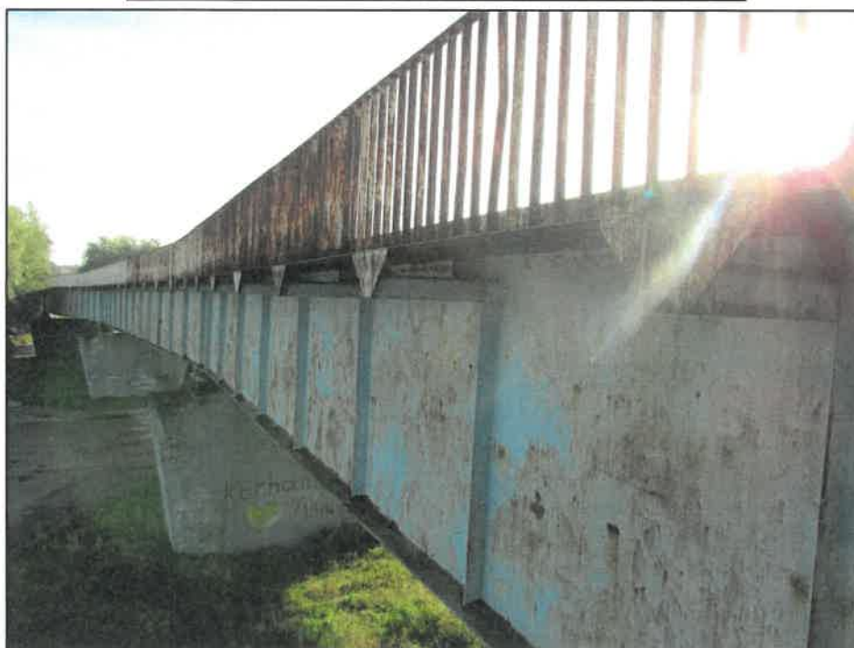
Fot. 1 Widok na most z boku
