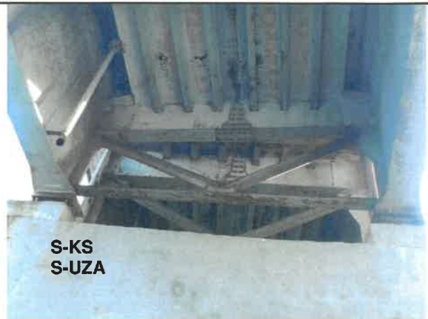
Fot. 5 Widok na stężenia poprzeczne w blachownicy na podporą.
