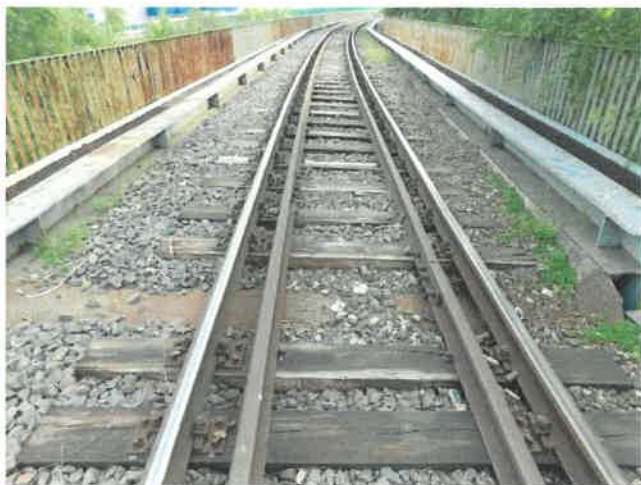
Fot. 82 Widok na nawierzchnię torową w prześle 16. Stan techniczny dobry.
