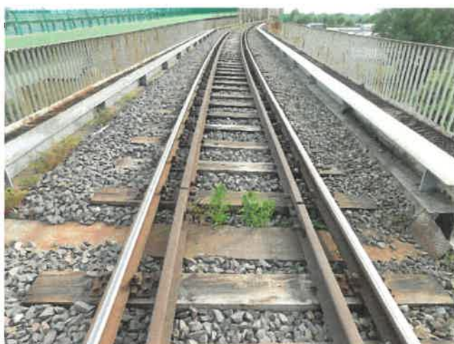
Fot. 80 Widok na nawierzchnię torową w prześle 14. Stan techniczny dobry.
