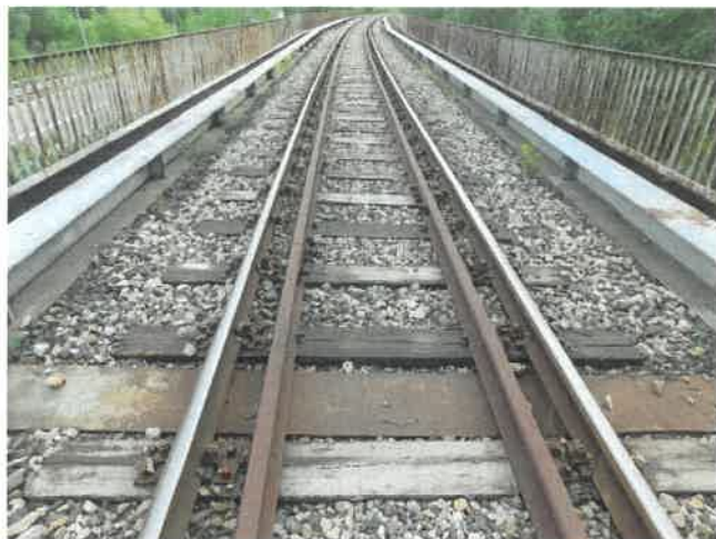
Fot. 77 Widok na nawierzchnię torową w prześle 3. Stan techniczny dobry.
