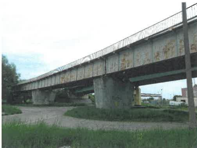
Fot. 5 Widok na przęsła blachownicowe po prawej stronie brzegu.
