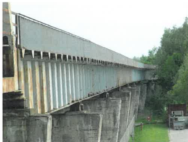
Fot. 2 Widok obiektu z boku w części blachownicowej od strony dolnej wody.
