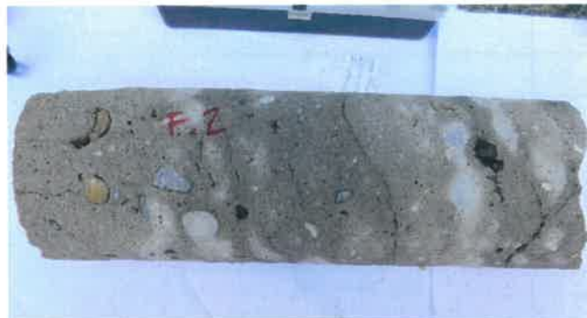
Fot. 20 Próbką rdzeniowa F.2 pobrana z podpory F.
