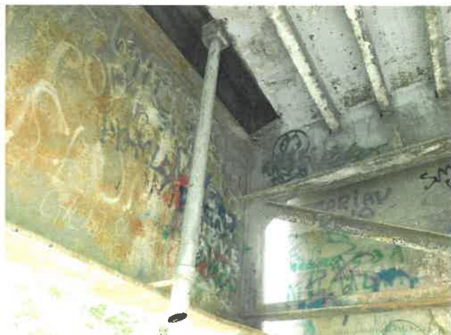
Fot. 186 Widok na rurę spustową w przęśle 17.
