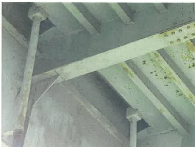
Fot. 187 Widok na rurę spustową w przęśle 6.
