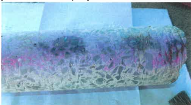
Fot. 36 Próbka rdzeniowa S.1 pobrana z podpory S po badaniu karbonatyzacji.
