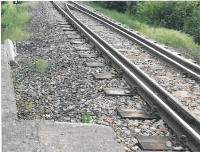
Fot. 172 Widok na strefę przejściową po stronie Tropów.
