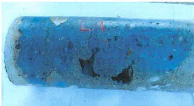
Fot. 34 Próbka rdzeniowa L.1 pobrana z podpory L po badaniu karbonatyzacji.
