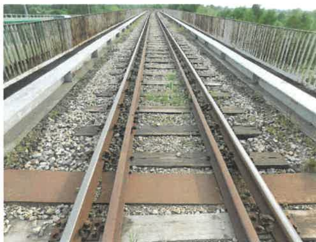
Fot. 8 Widok nawierzchni kolejowej i chodnika służbowego w części blachownicowej obiektu.
