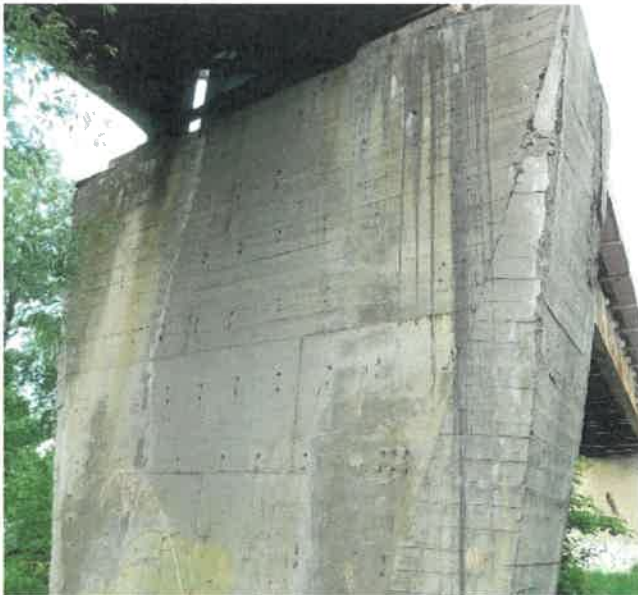
Fot. 113 Widok od strony Braniewa. Spękania otuliny betonowej. Osady i wykwyty na betonie, białe przebarwienia betonu.
