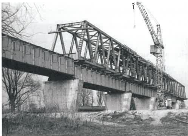
Fot. 3 Zdjęcie z budowy przedmiotowego obiektu z 1976 r. – przęsła kratowe.
