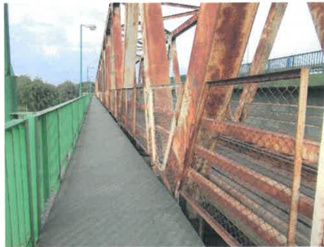
Fot. 191 Widok na powierzchnię kładki dla pieszych.
