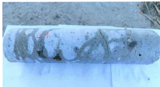
Fot. 22 Próbką rdzeniowa L.1 pobrana z podpory L.
