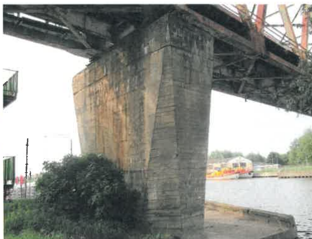
Fot. 13 Widok na podporę pośrednią.
