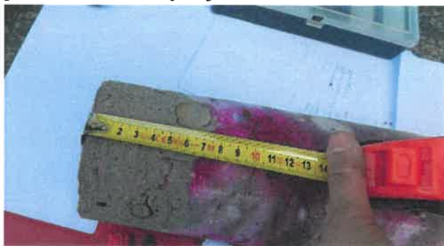
Fot. 33 Próbka rdzeniowa F.2 pobrana z podpory F po badaniu karbonatyzacji.
