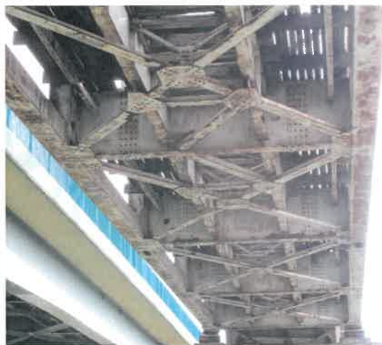
Fot. 10 Widok ogólny na spód konstrukcji.
