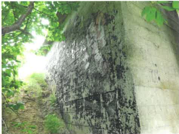
Fot. 103 Widok na skrzydło prawe.
