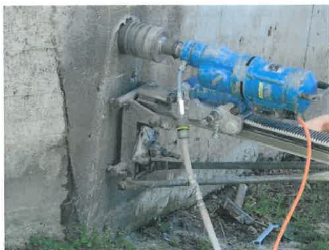
Fot. 14 Pobieranie próbki rdzeniowej z podpory F.
