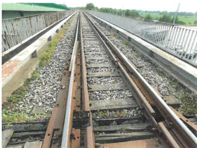
Fot. 79 Widok na nawierzchnię torową w prześle 9 od strony prześla kratowego. Widoczny przyrząd wyrównawczy oraz dylatacja na odbojnicy.
