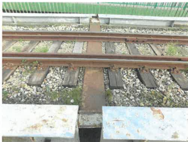
Fot. 78 Widok na nawierzchnię torową na styku prześla 7 i 6. Stan techniczny dobry.
