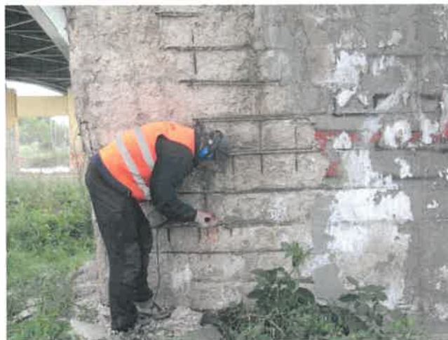
Fot. 40 Pobranie pręta zbrojeniowego z podpory M.
