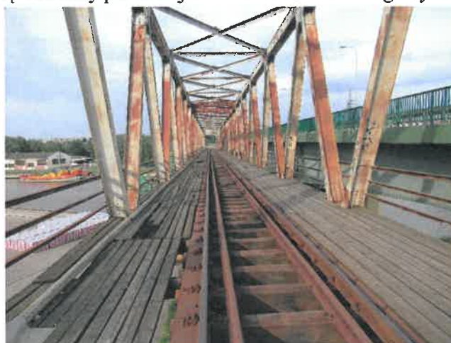
Fot. 11 Widok nawierzchni kolejowej na obiekcie i chodników służbowych.
