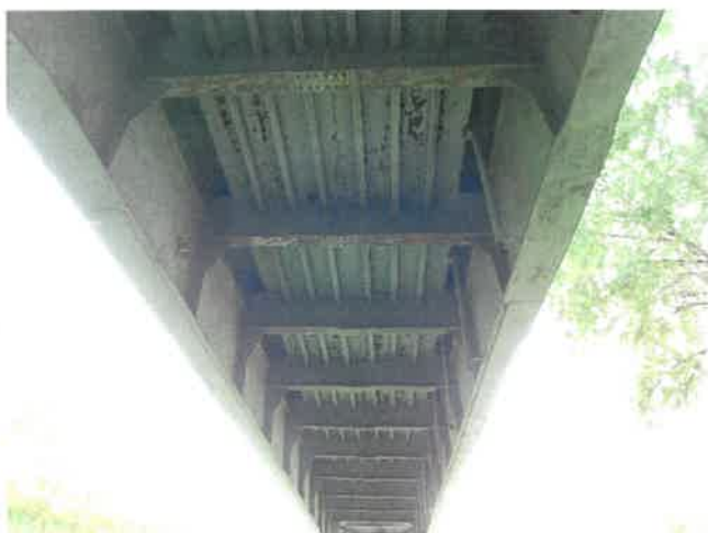
Fot. 7 Widok ogólny na spód konstrukcji nośnej przęsła blachownicowego.
