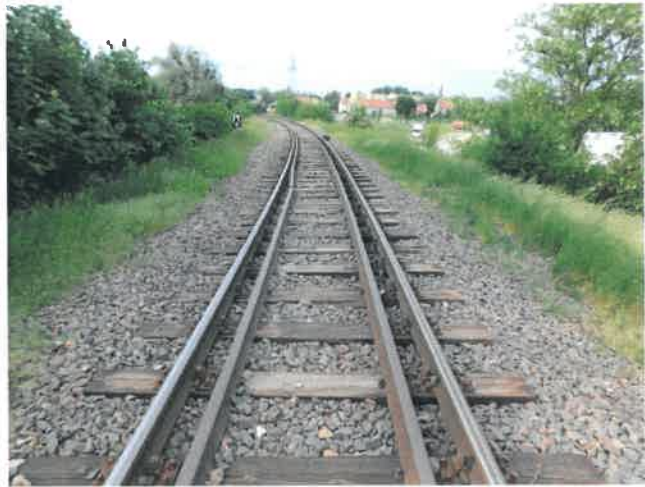
Fot. 173 Widok na strefę przejściową po stronie Braniewa.
