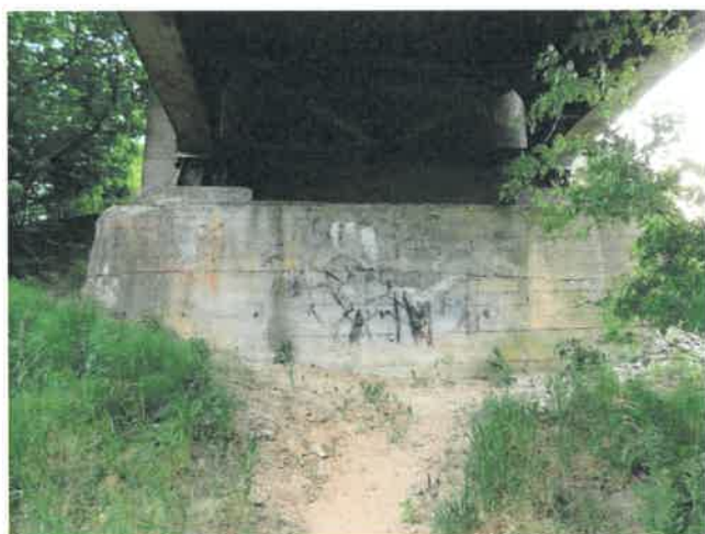
Fot. 12 Widok na przyczółek.
