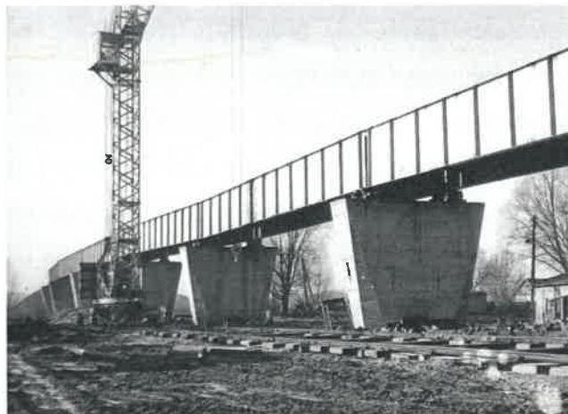
Fot. 4 Zdjęcie z budowy przedmiotowego obiektu z 1976 r. – przęsła blachownicowe.
