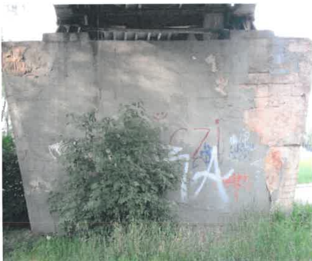
Fot. 166 Widok od strony Tropów.
