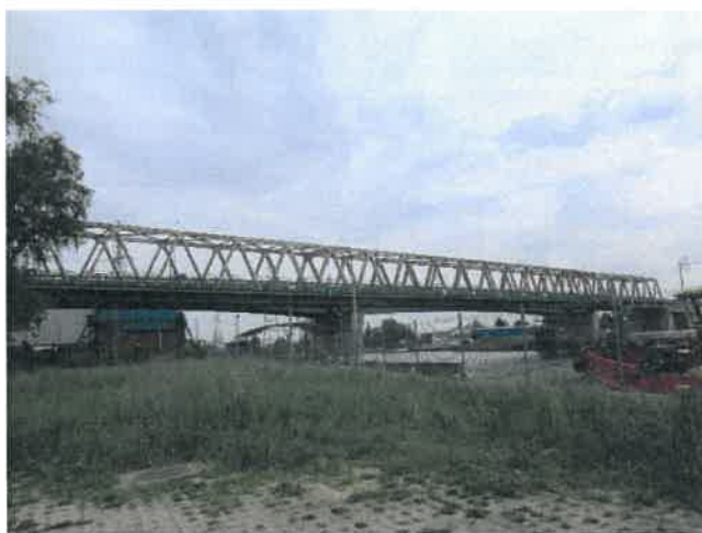
Fot. 9 Widok na kratownicę od strony północnej.
