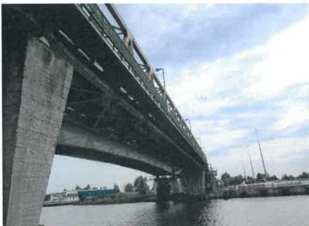
Fot. 174 Widok na przestrzeń pod przęsłem 11 nurtowym.
