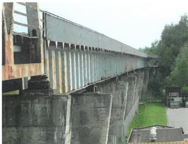
Fot. 6 Widok na przęsła blachownicowe po lewej stronie brzegu.
