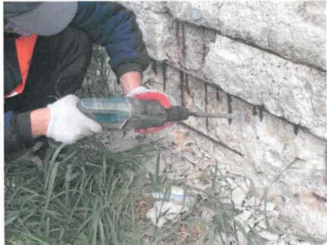
Fot. 39 Odkuwanie zbrojenia na podporze M.
