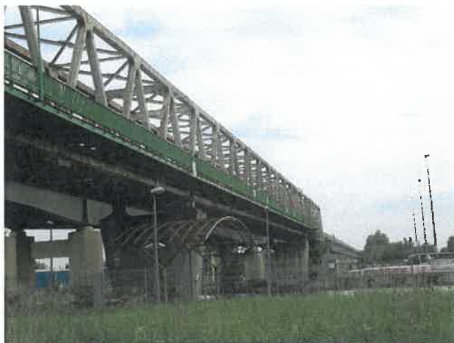
Fot. 1 Widok obiektu z boku w części kratowej od strony dolnej wody.
