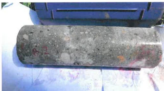
Fot. 18 Próbką rdzeniowa B.2 pobrana z podpory B
