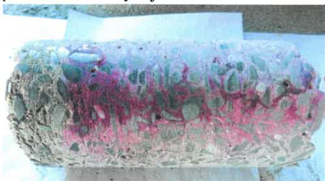
Fot. 37 Próbka rdzeniowa S.2 pobrana z podpory S po badaniu karbonatyzacji.
