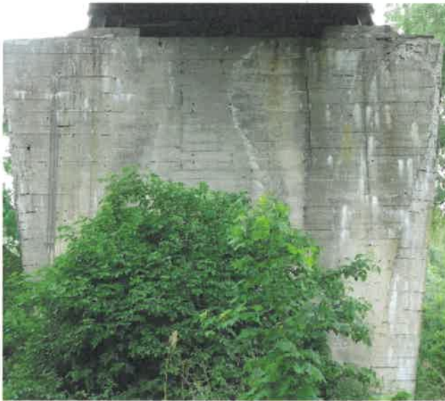
Fot. 113 Widok od strony Braniewa. Spękania otuliny betonowej. Osady i wykwyty na betonie, białe przebarwienia betonu.
