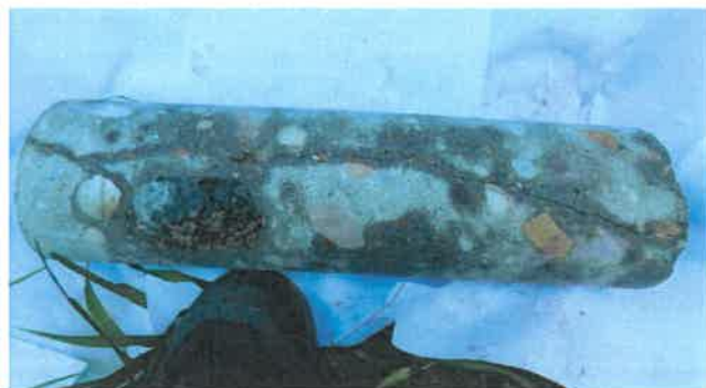
Fot. 16 Próbk rdzeniowa B.1 pobrana z podpory B.
