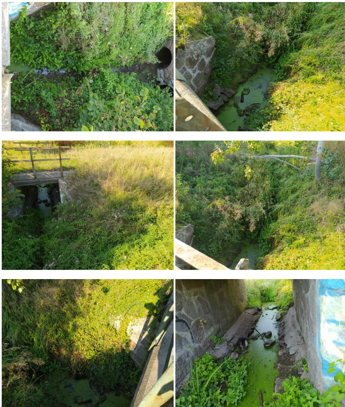
Fot. 5.8.1. Widoczna roślinność w obrębie przyczółków i skrzydeł przepustu.
