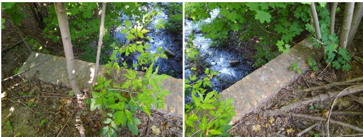
Fot. 5.3.1. Widoczne m.in. ubytki fragmentów cegieł na gzymsach, wegetacja roślinności.
