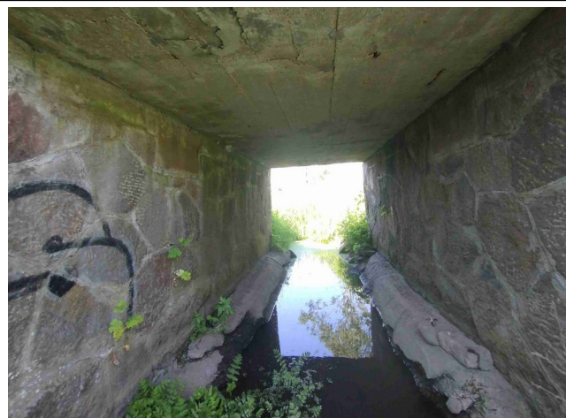
Fot. 4.2 Płyta denna i fundamenty – widok 2
