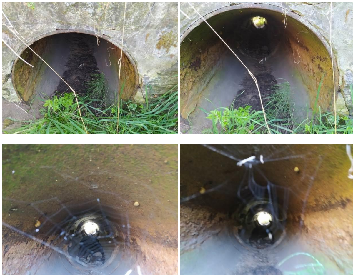
Fot. 5.3.1. Widoczna korozja elementów stalowych, częściowy rozpad stalowych łączników, zanieczyszczenia wewnątrz rury.
