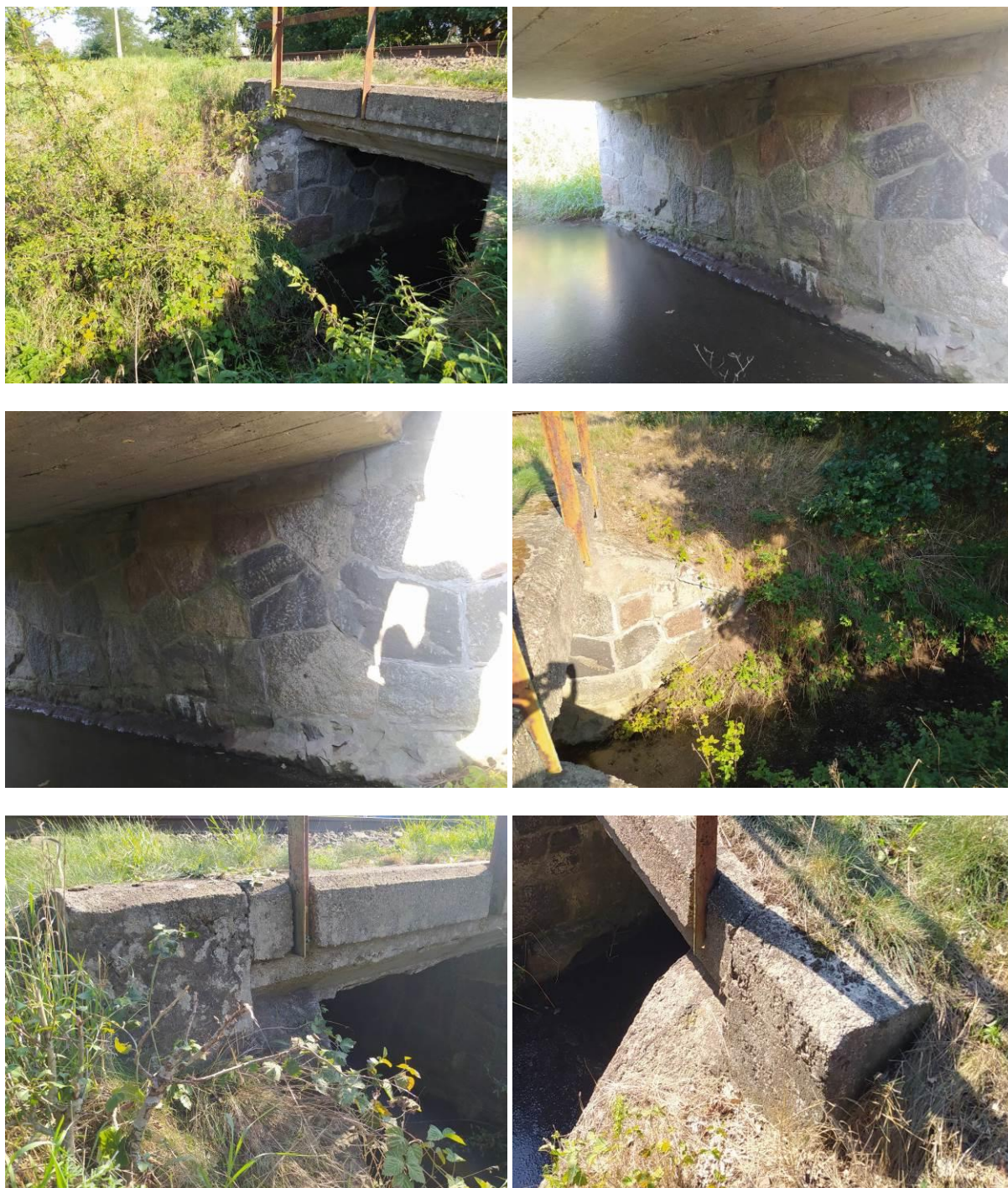
Fot. 5.3.1. Widoczny stan techniczny przyczółków i skrzydeł przepustu po stronie stacji Aleksandrów Kujawski i Ciechocinek.
