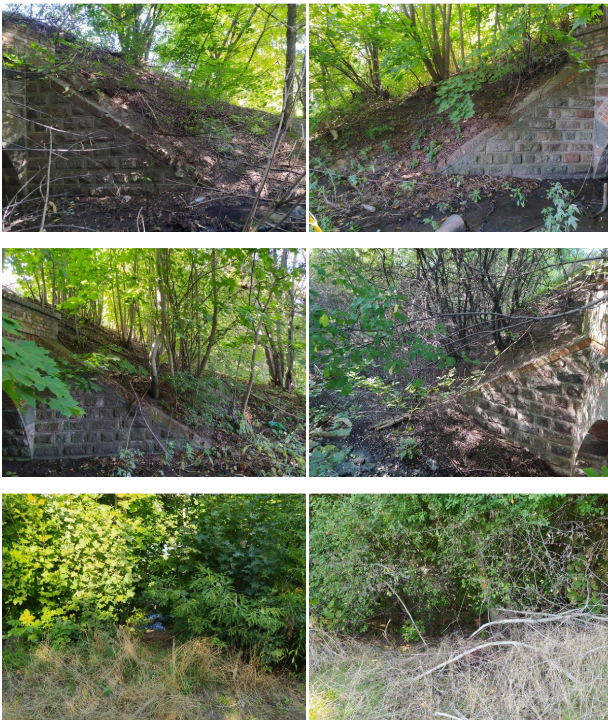
Fot. 5.8.1. Widoczna stan skarp na wlocie i wylocie przepustu.
