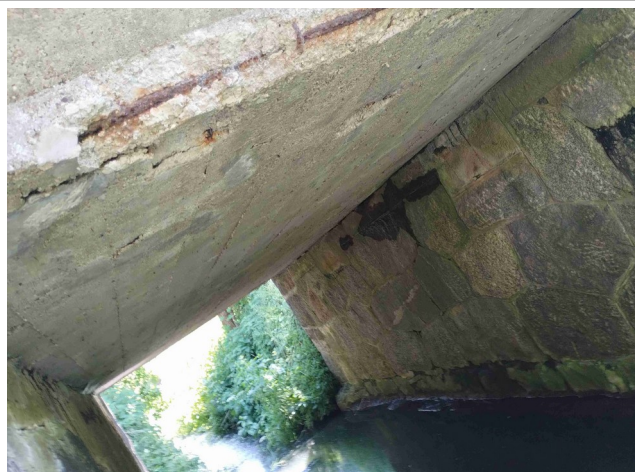
Fot. 9.2 Uszkodzenia izolacji – widok 2.
