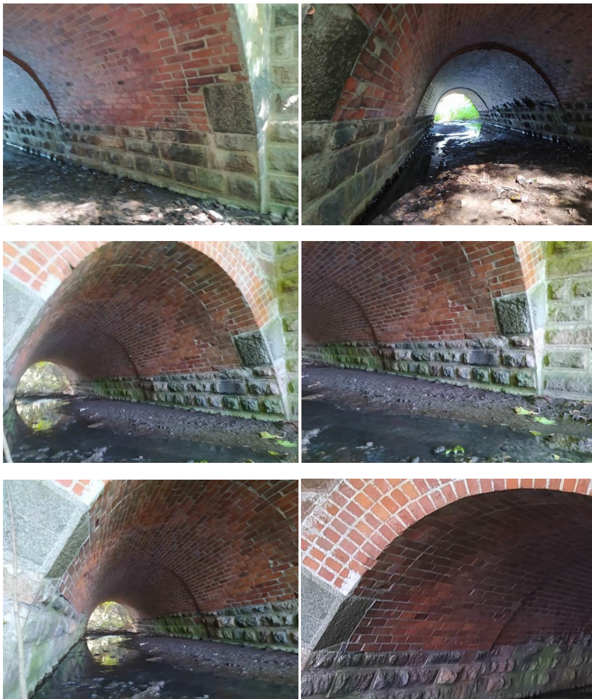
Fot. 5.4.1. Widoczne ubytki miejscowe fragmentów cegieł, pęknięcia wzdłuż ścian czołowych.
