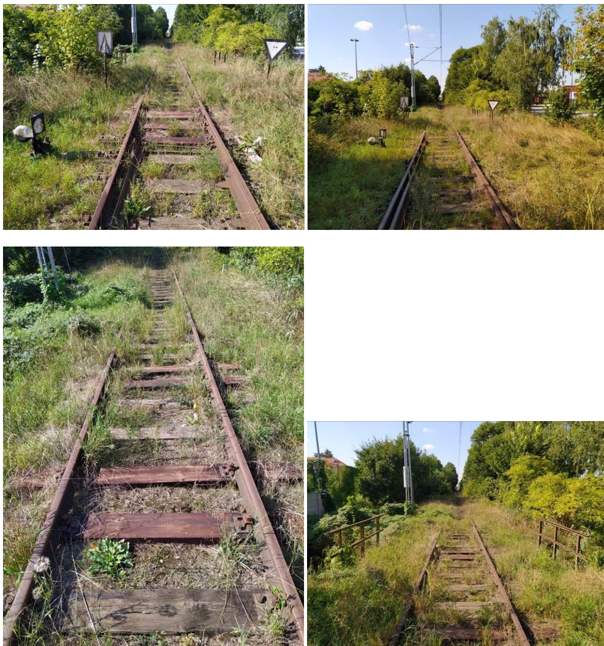
Fot. 5.2.1. Widoczne ubytki tłucznia, wegetacja roślinności. Strefy przejściowe dobrze zagęszczone bez odkształceń. Degradacja podkładów drewnianych.
