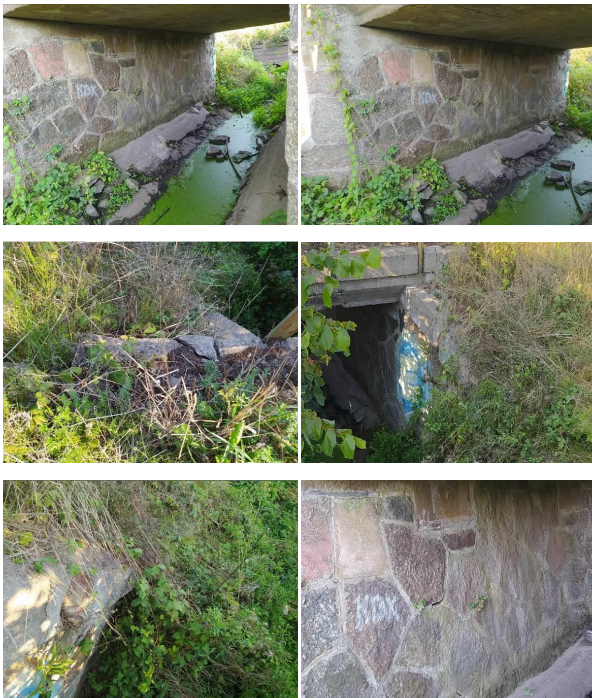
Fot. 5.3.1. Widoczne stan techniczny przyczółków i skrzydeł przepustu po stronie stacji Aleksandrów Kujawski i Ciechocinek.
