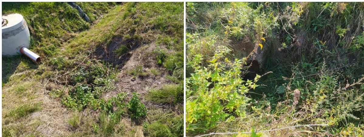
Fot. 5.8.1. Widoczna stan skarp na wlocie i wylocie przepustu.
