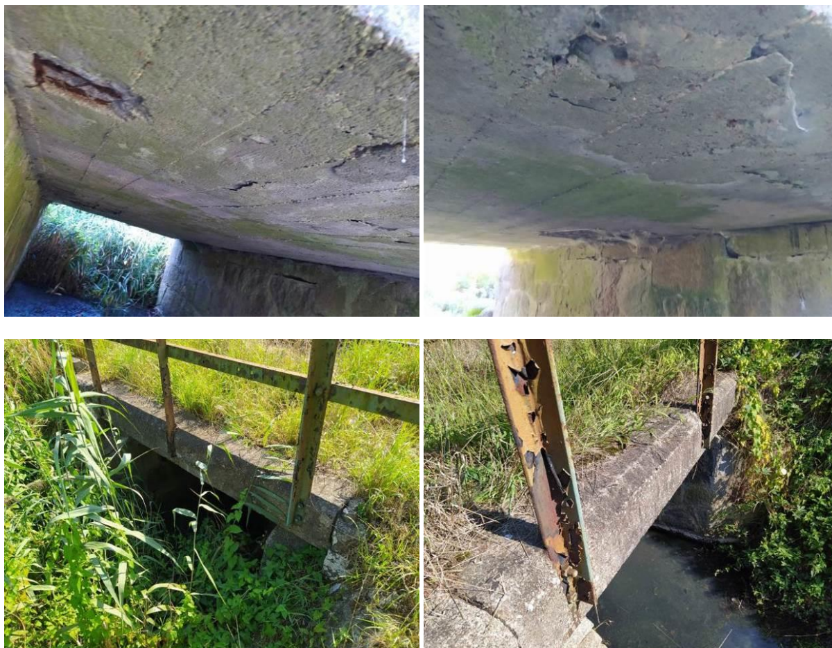
Fot. 5.4.1. Widoczna ubytki otuliny prętów zbrojeniowych, przecieki, zawilgocenia, wykwyty.
