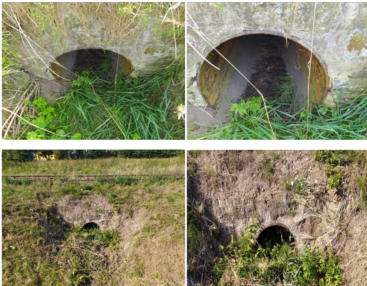
Fot. 5.4.1. Widoczne zanieczyszczenia, brak gzymsów i wegetacja roślinności.
