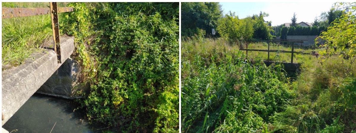
Fot. 5.8.1. Widoczna roślinność w obrębie przyczółków i skrzydeł przepustu.
