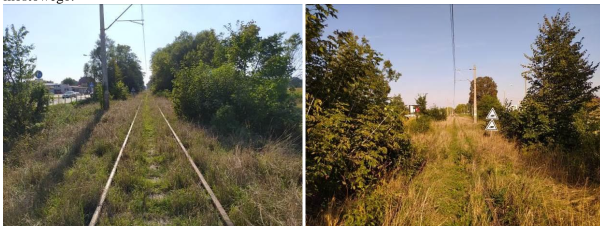
Fot. 5.2.1. Widoczna wegetacja roślinności utrudniająca ocenę stanu technicznego stref przejściowych. Tory w strefach przejściowych bez odkształceń co może świadczyć o dobrym zagęszczeniu gruntu.
