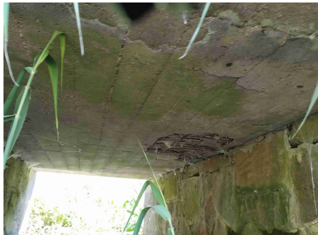
Fot. 9.2 Uszkodzenia izolacji – widok 2.
