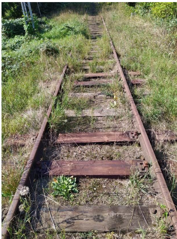
Fot. 5.6.1. Widoczne zanieczyszczenia tłucznia, ubytki podsypki tłuczniowej, odsłonięte podkłady drewniane, degradacja podkładów drewnianych, wegetacja roślinności.
