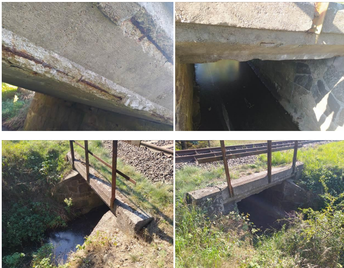
Fot. 5.4.1. Widoczna ubytki otuliny prętów zbrojeniowych, przecieki, zawilgocenia, wykwyty, wegetacja roślinności.
