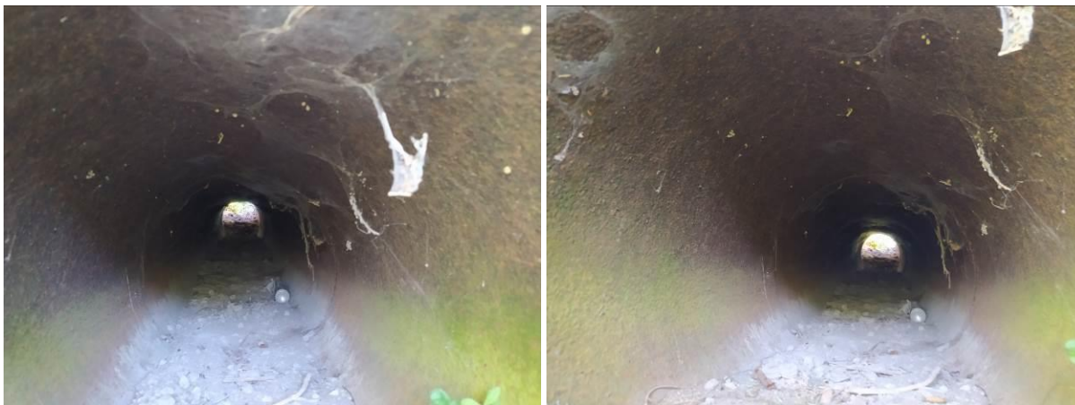
Fot. 5.3.1. Widoczna korozja elementów stalowych, zanieczyszczenia wewnątrz rury.
