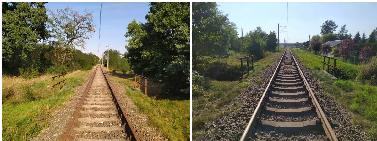
Fot. 5.2.1. Tor w strefach przejściowych bez odkształceń co może świadczyć o dobrym zagęszczeniu gruntu.
