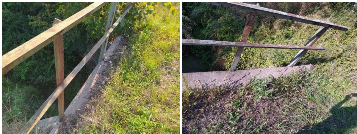
Fot. 5.4.1. Widoczna ubytki otuliny prętów zbrojeniowych, przecieki, zawilgocenia, wykwyty, wegetacja roślinności.
