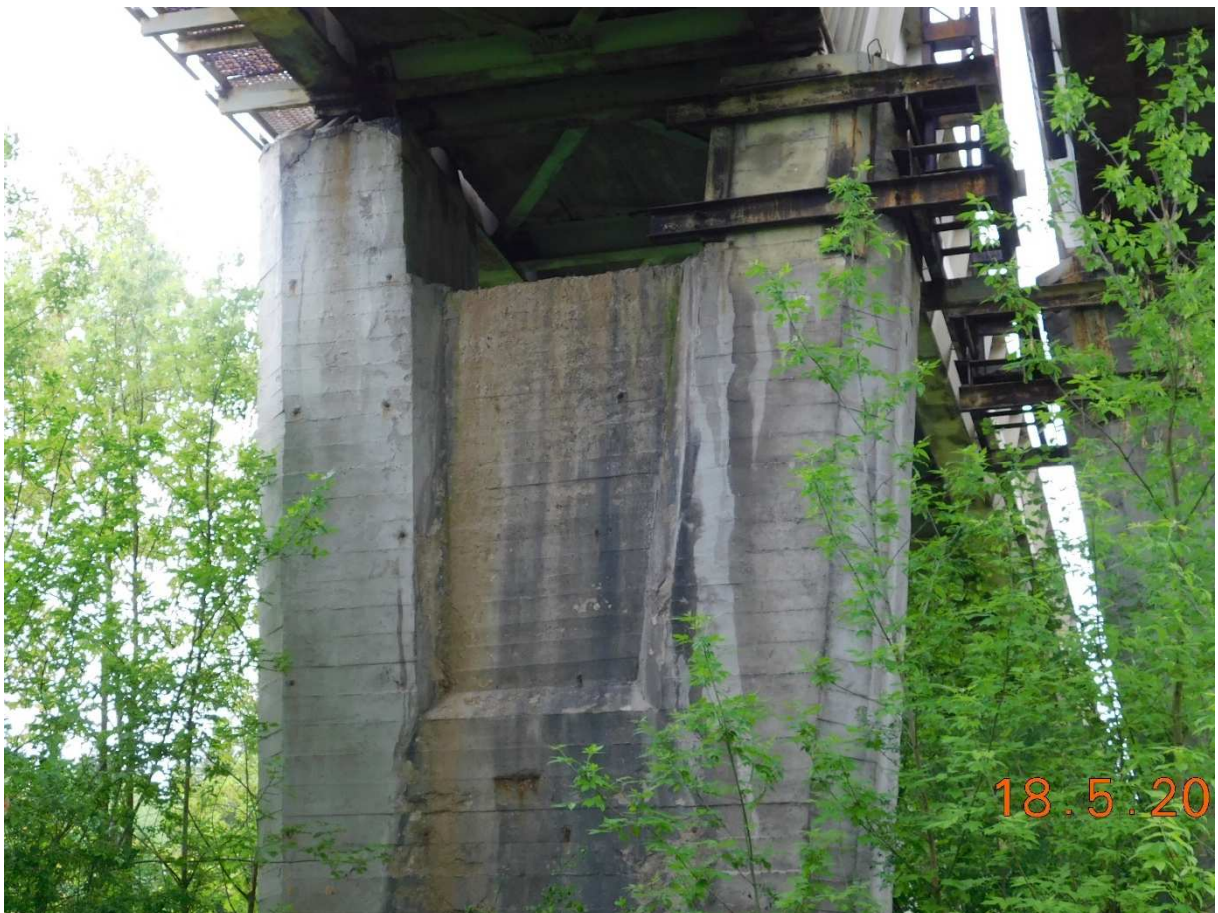
Rys. 3.6 Widok na przykładową podporę pośrednią wiaduktu
