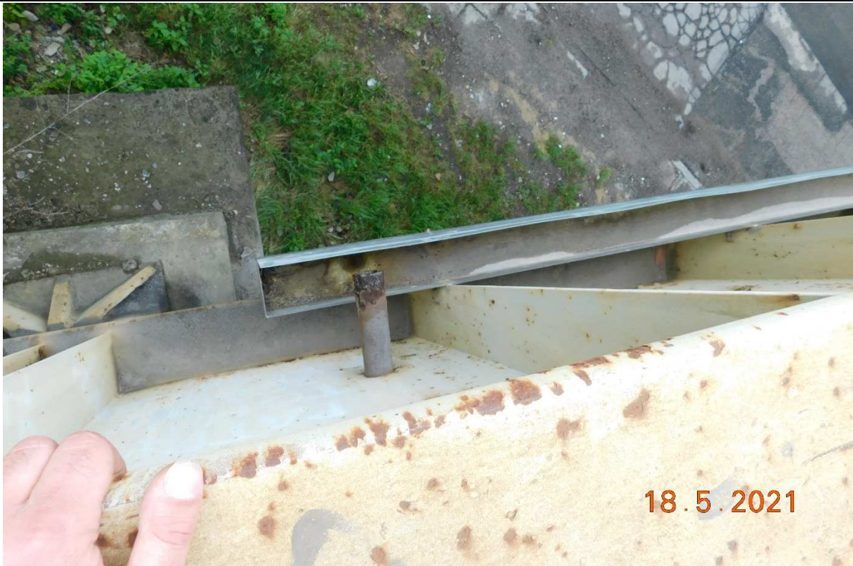
Rys. 3.11 Sączek odwodnieniowy odprowadzający wodę opadową do stalowego koryta
