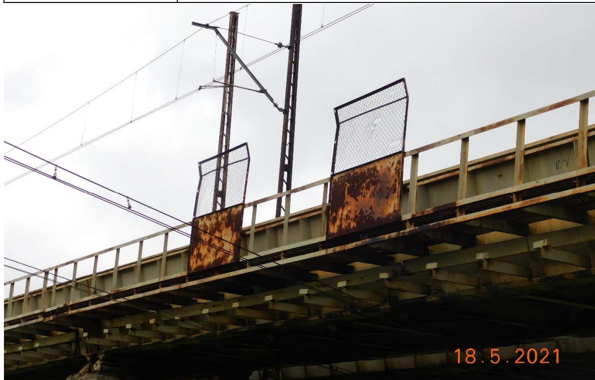
Rys. 3.10 Ekran przeciwporażeniowy nad torem linii kolejowej nr 8
