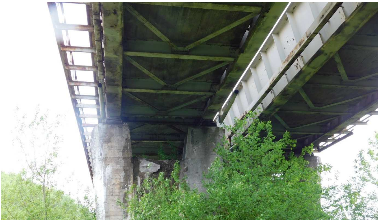
Rys. 3.3 Przęsło wiaduktu – widok od spodu
